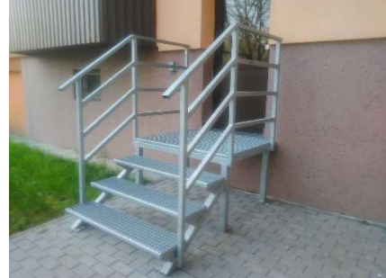
21. Pr. schodiska so stupňovými klinmi kotvenými zhora do bočných schodníc
